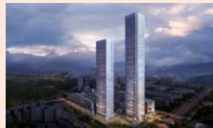
Shum Yip Upperhills Tower 1 388 м, 80 этажей, открыто в 2019 году
